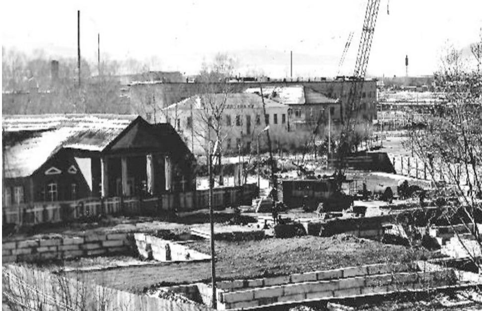
Панорама стройки нового Дома культуры в с. Бея, 1986 год. Архив муниципального образования Бейский район Ф.Р-76. Оп. 1 Д. 165. Фотография
